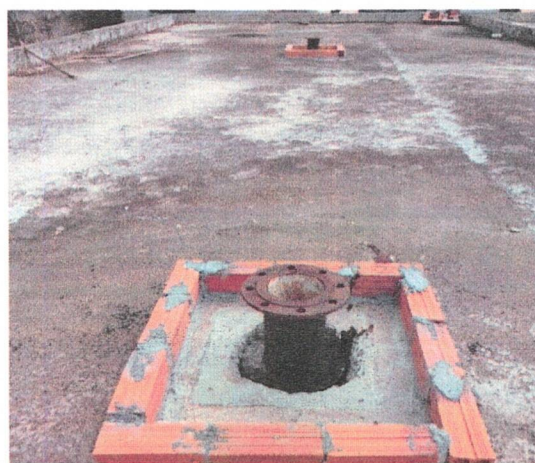
Montagem de Inserts do RAP - Oriximiná-Pa.
