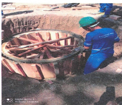
Concretagem do anel de fundo da estação elevatória de esgoto - Alter do Chão-Santarém-Pa.
