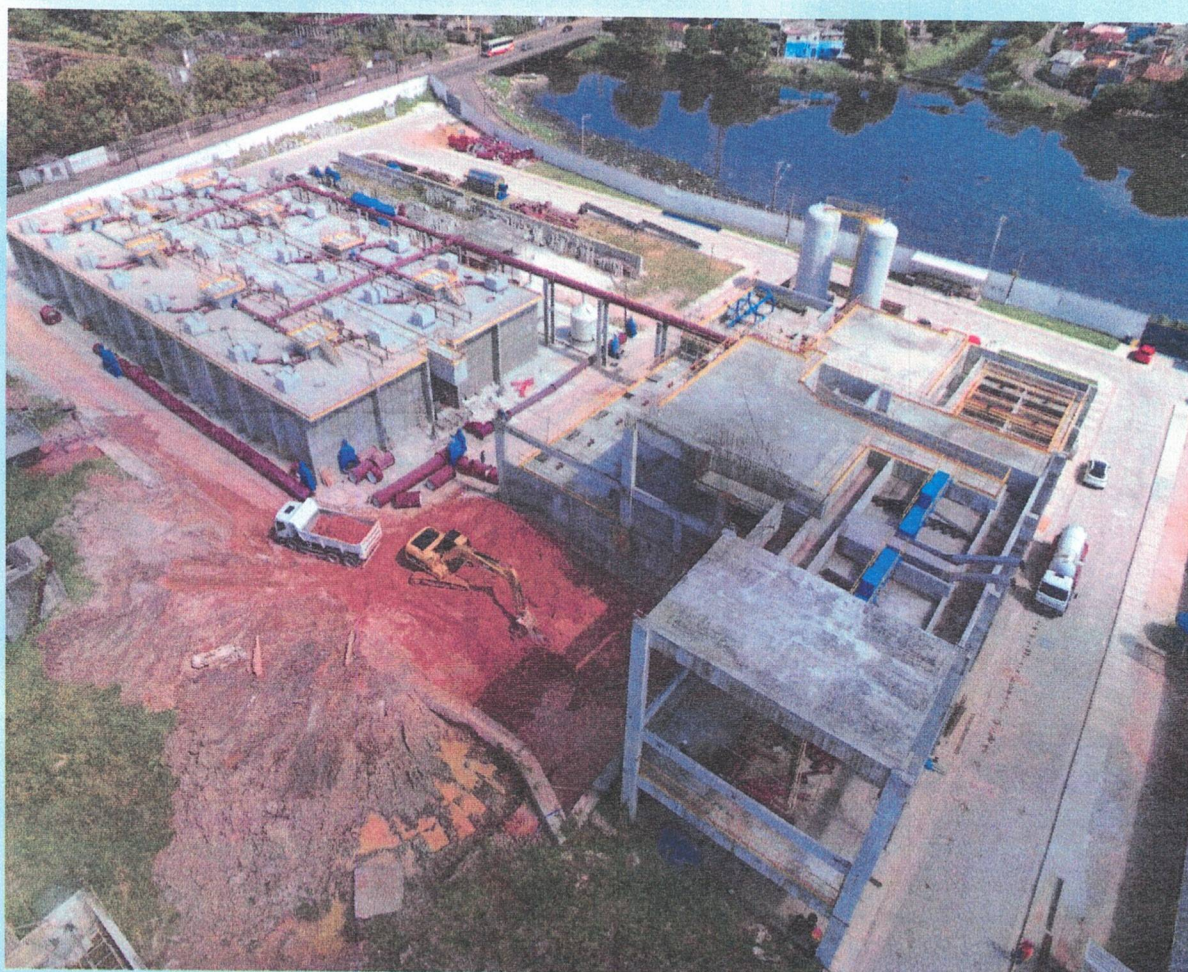
Vista aérea da Construção da Estação de Tratamento de Esgoto Sanitário - ETE UNA
