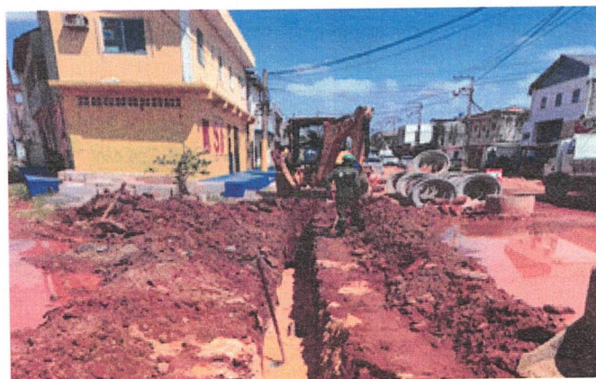
Assentamento de Redes de Água no bairro Montese (Terra Firme) – Município de Belém
