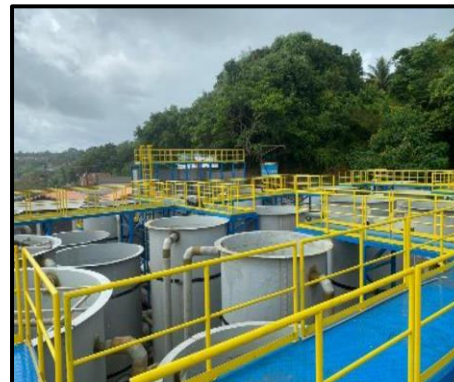
Estação de Tratamento de Água do Município de Oriximiná
