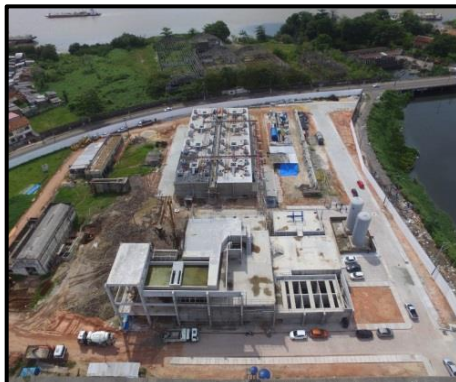
Área da Construção da Estação de Tratamento de Esgoto do Una Belém - PA
