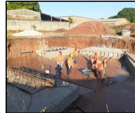
Construção das Sapatas do Reservatório Elevado da Estação de Tratamento de Água do Município de Alenquer-Pa
