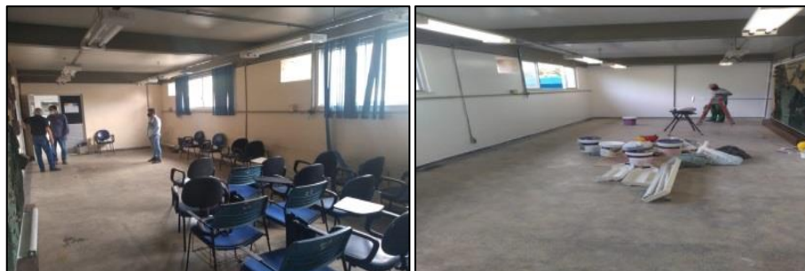
Auditório do Complexo - ETA-BOLONHA
