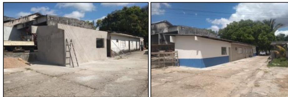
Setor de Transporte (em andamento)
