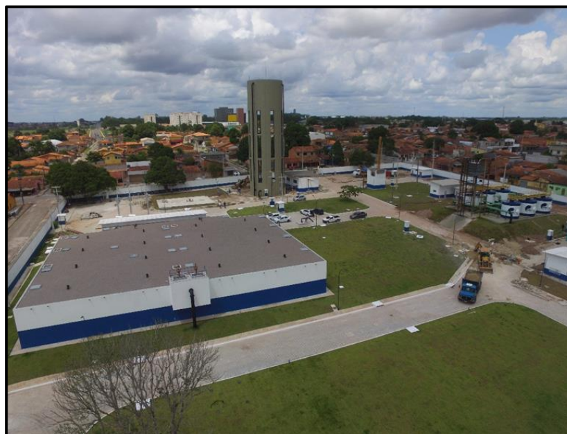
Estação de Tratamento de Água do setor Jaderlândia/Santa Catarina Município de Castanhal
