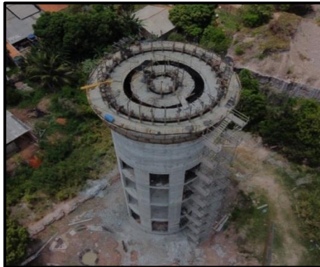
Construção da Estação Elevatória do Sistema de Abastecimento de Água do Município de Santarém-Pa
