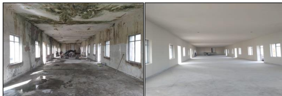
Estação de Tratamento de Água - SÃO BRÁS
