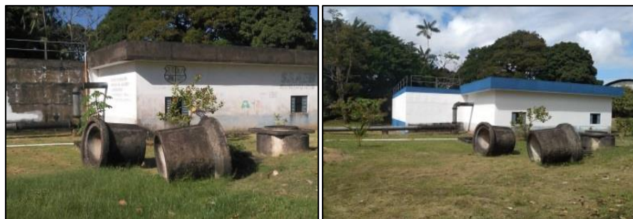
Sistema de Bombeamento da Quinta Rua no Mosqueiro
