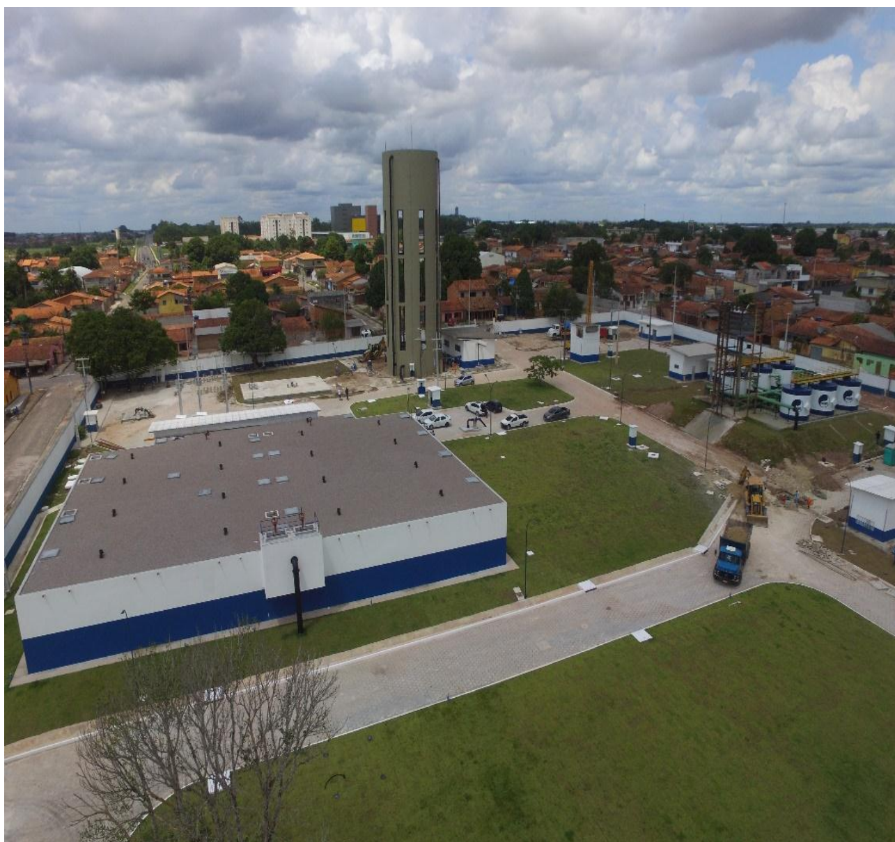
Sistema de Abastecimento de Água do Município de Castanhal – Setor Jaderlandia
