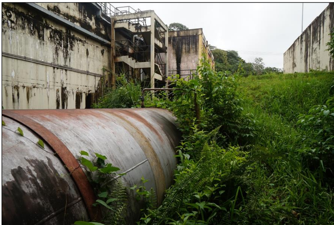
Figura 6.3 – Ponto de aplicação de coagulante diretamente na adutora de água bruta
