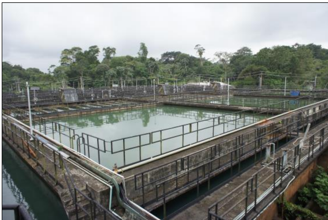
Figura 2.8 – Vista geral dos decantadores implantados em segunda etapa na ETA Bolonha - Decantadores de alta taxa
