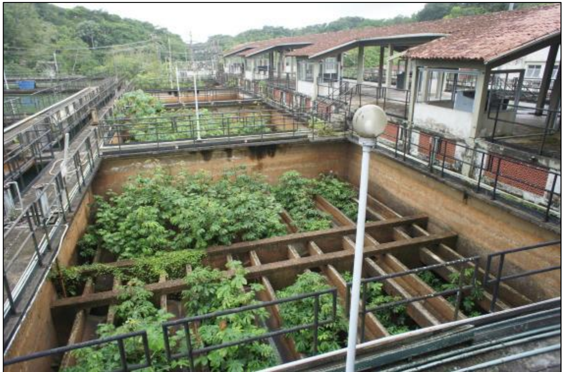
Figura 2.11 – Vista geral das unidades de filtração implantadas em segunda etapa na ETA Bolonha - Filtros rápidos por gravidade do tipo dupla camada areia e antracito
