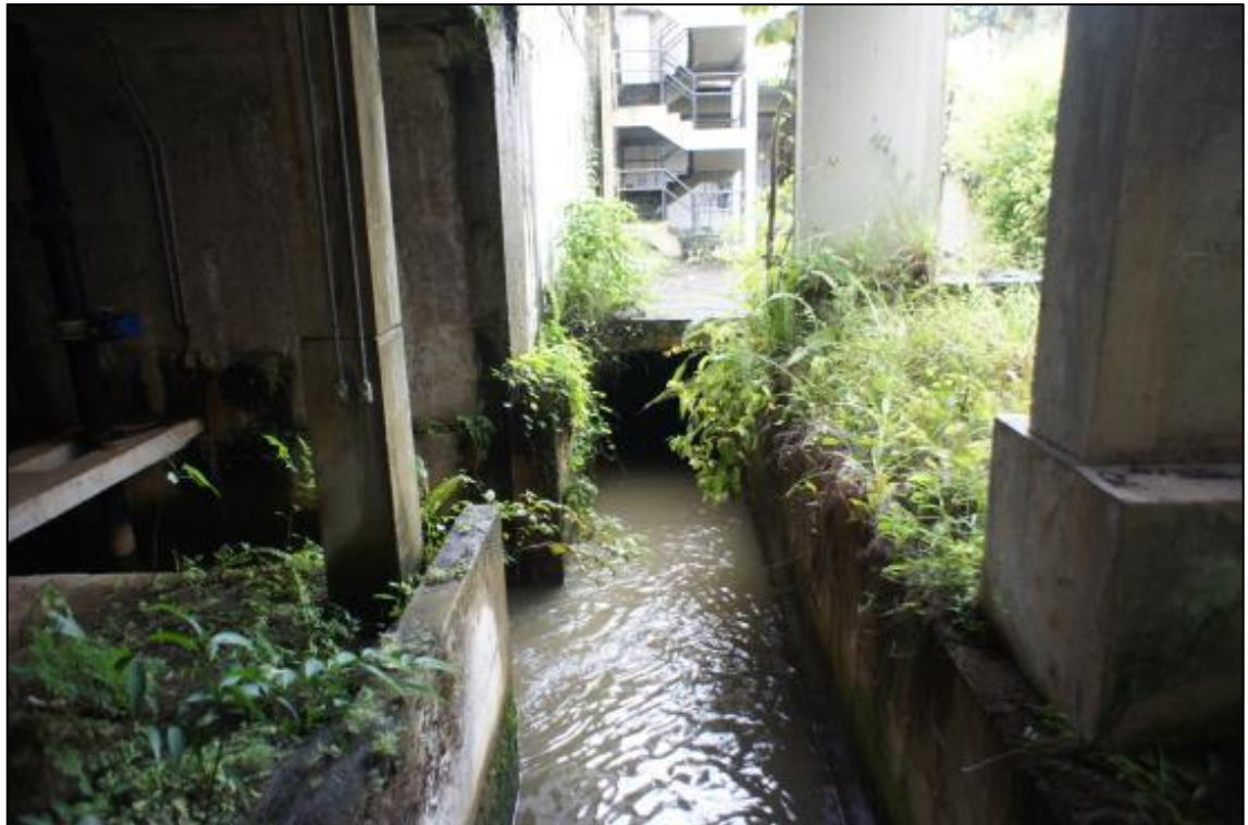
Figura 4.13 – Vista geral do canal comum de recebimento de água de lavagem dos filtros e descarga de lodo dos decantadores
