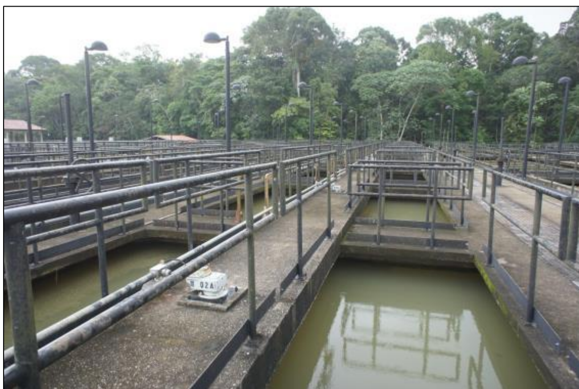
Figura 2.6 – Vista geral das unidades de floculação mecanizadas implantada ETA Bolonha – Etapa
