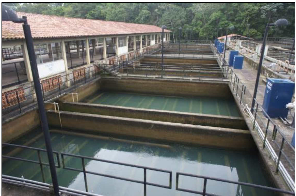
Figura 2.11 – Vista geral das unidades de filtração implantadas em segunda etapa na ETA Bolonha - Filtros rápidos por gravidade do tipo dupla camada areia e antracito
