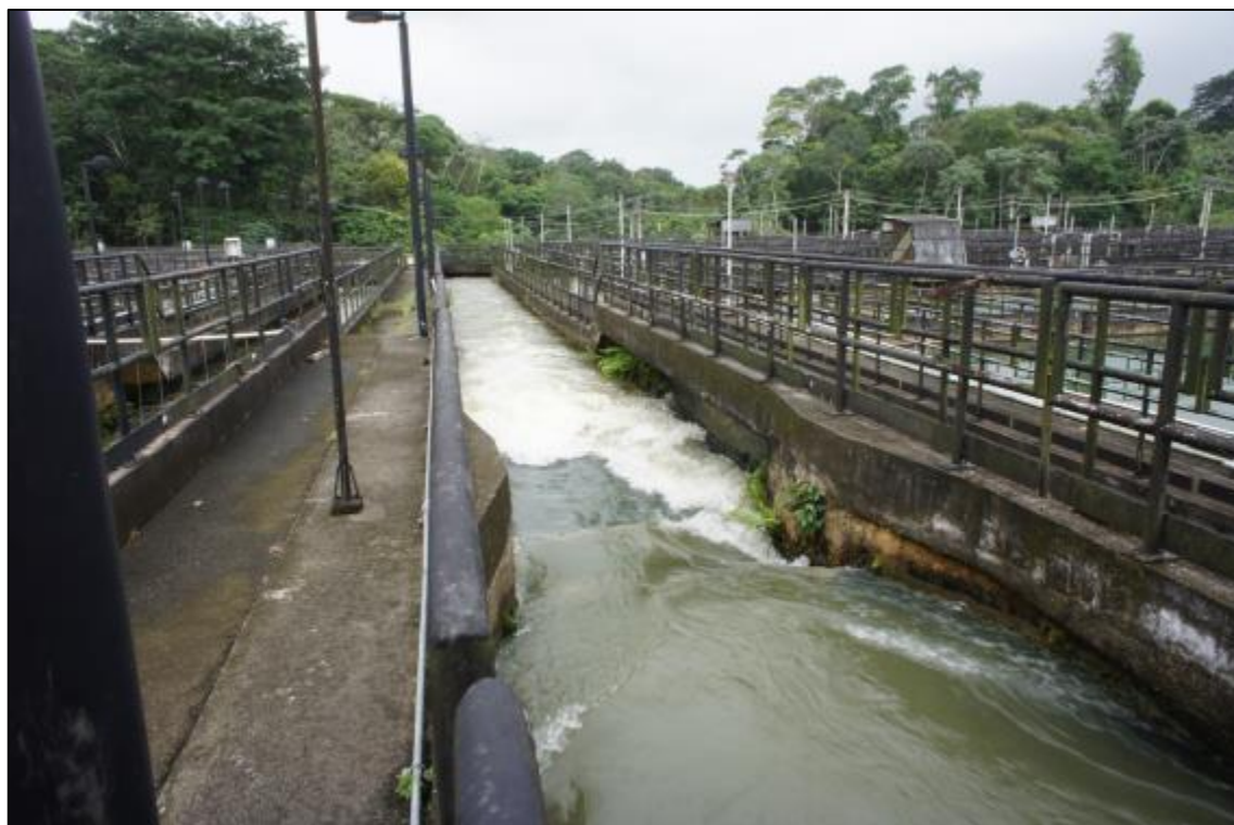
Figura 2.2 – Vista geral do canal de chegada de água bruta e Calha Parshall instalada na Etapa 2 – ETA Bolonha
