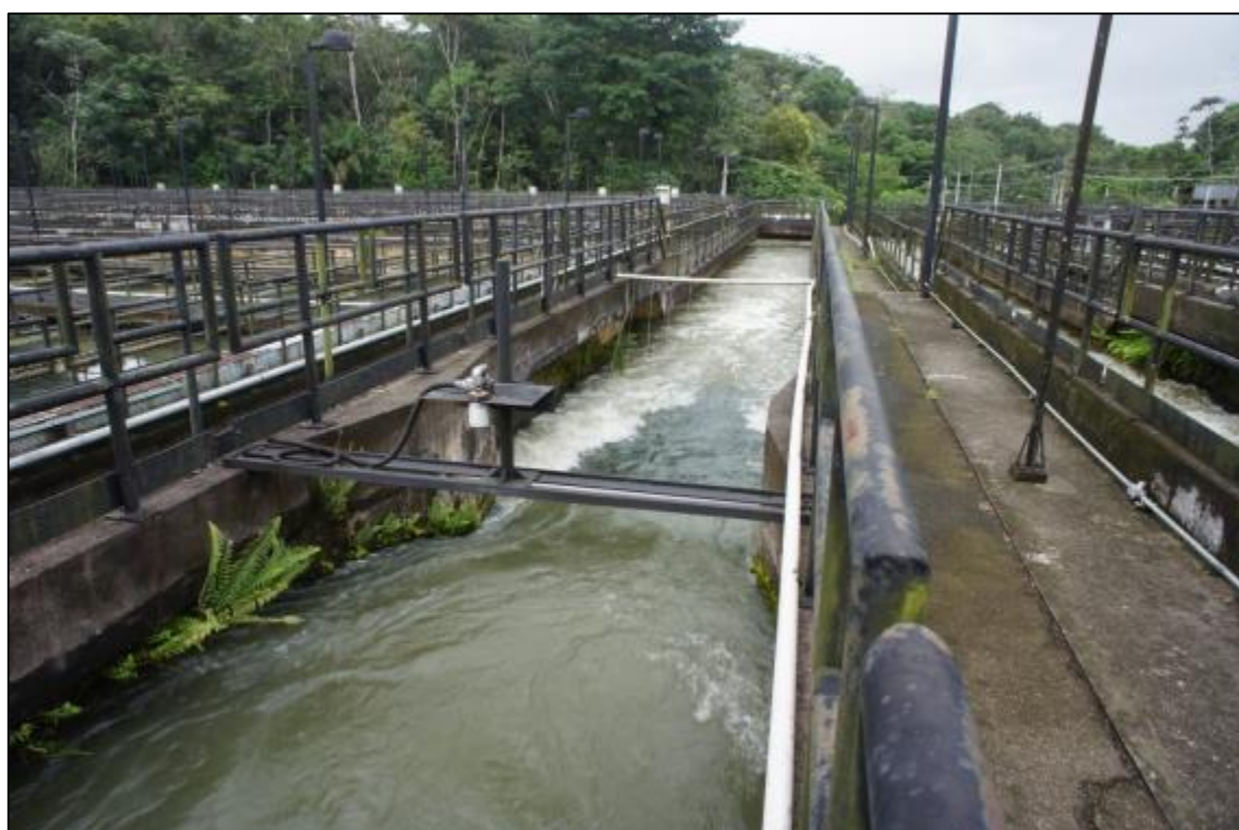
Figura 2.2 – Vista geral do canal de chegada de água bruta e Calha Parshall instalada na Etapa 2 – ETA Bolonha
