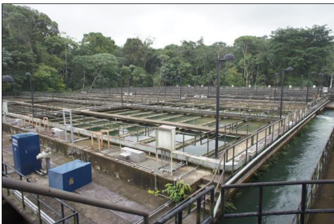
Figura 2.8 – Vista geral dos decantadores implantados em segunda etapa na ETA Bolonha - Decantadores de alta taxa
