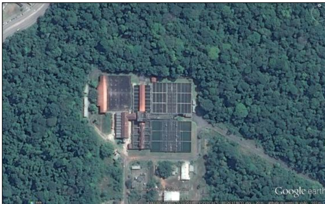
Figura 1.2 – Vista geral da ETA Bolonha e disposição de seus processos unitários de tratamento
