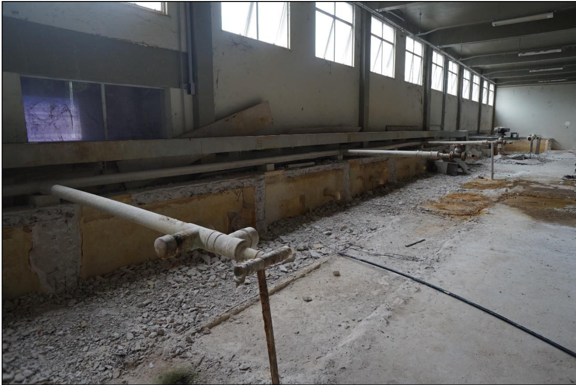
Figura 6.4 – Sistema de preparação de suspensão de cal hidratada como agente pré e pós alcalinizante desativado
