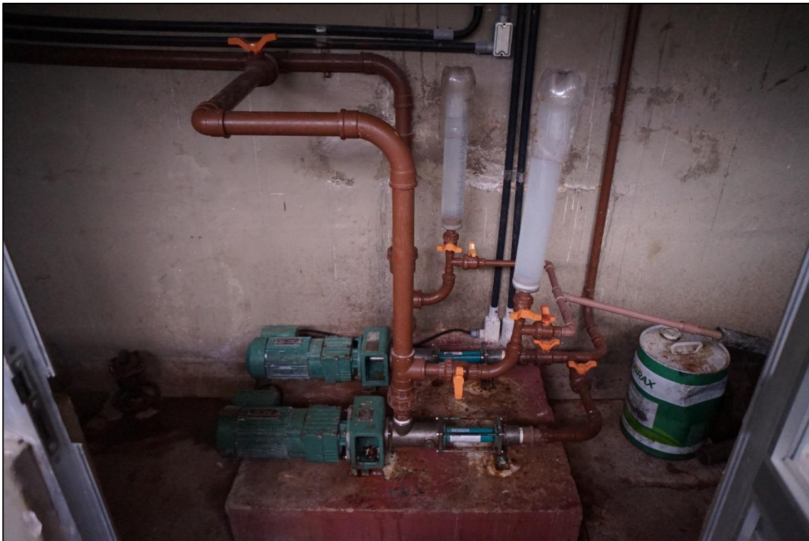
Figura 6.2 – Bombas dosadoras de coagulante em operação na ETA Bolonha
