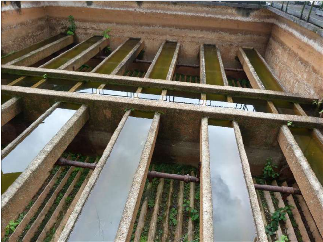
Figura 2.11 - Vista das canaletas que compõem os filtros.
