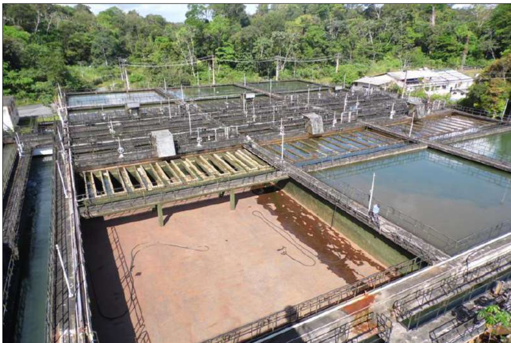
Figura 2.3 – Vista Panorâmica dos decantadores A e B
