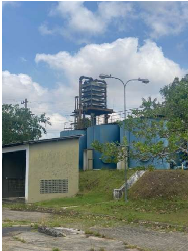
Figura 14: Estação de Tratamento de Água
