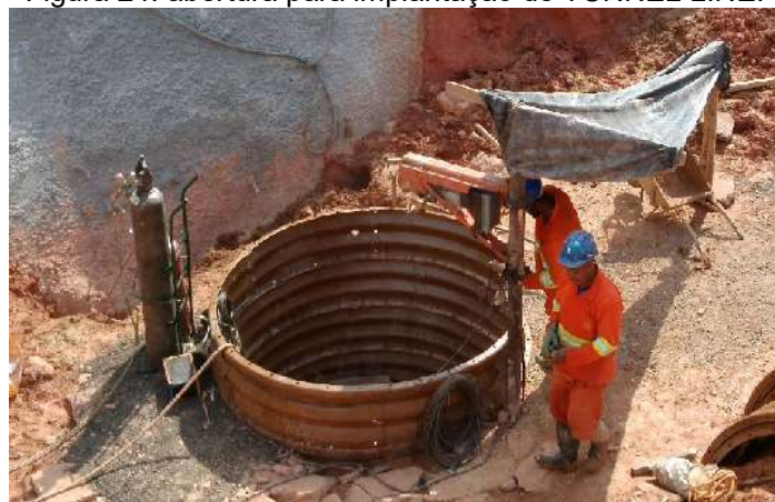
Figura 24: abertura para implantação de TUNNEL LINE.
