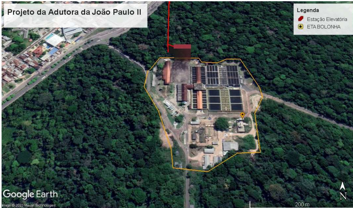
Figura 20: Detalhamento do Projeto da Adutora da João Paulo II. Estação Elevatória na ETA Bolonha.
