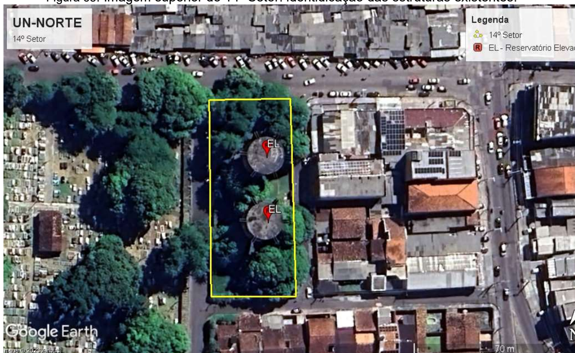
Figura 65: Imagem superior do 14º Setor. identificação das estruturas existentes.
