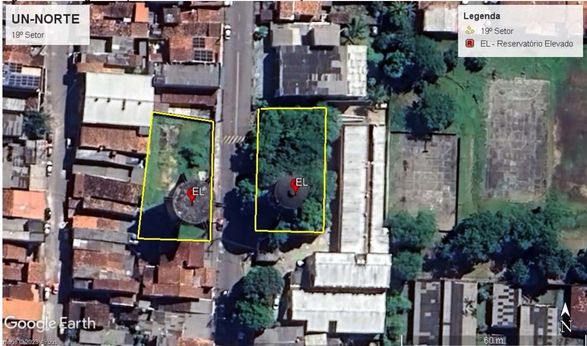
Figura 69: Imagem superior do 19º Setor. Identificação das Estruturas Existentes.
