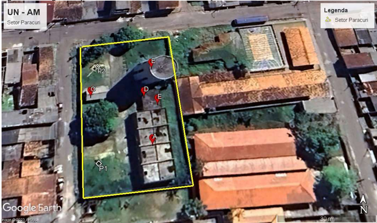
Figura 49: Poço 1 e clorador
