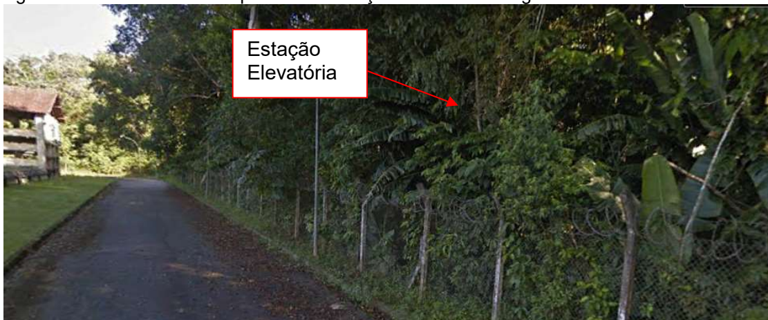
Figura 21: Área onde será implantada a estação elevatória de água tratada.
