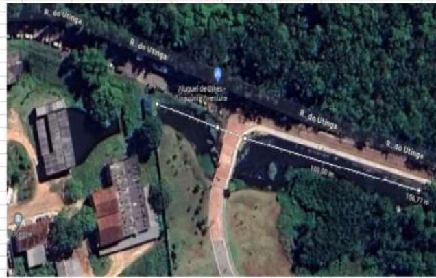
CANAL YUNA / CAPTAÇÃO UTINGA
