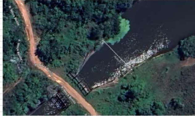
COMPORTAS DE CONTROLE DA TRANSFERÊNCIA DE ÁGUA DO LAGO ÁGUA PRETA PARA O LAGO BOLONHA
