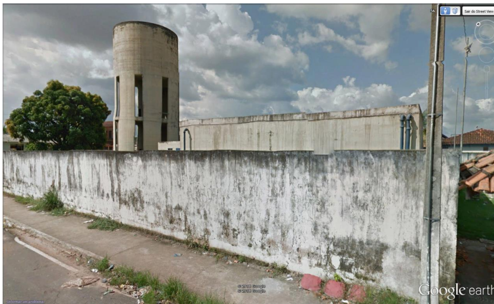
Figura 8: Imagem do Setor Paracuri – Reservatório Apoiado
