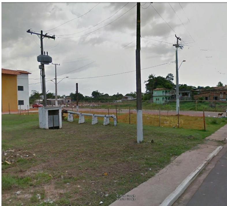
Figura 9: Imagem do Setor Souza Franco - Área do Poço existente
