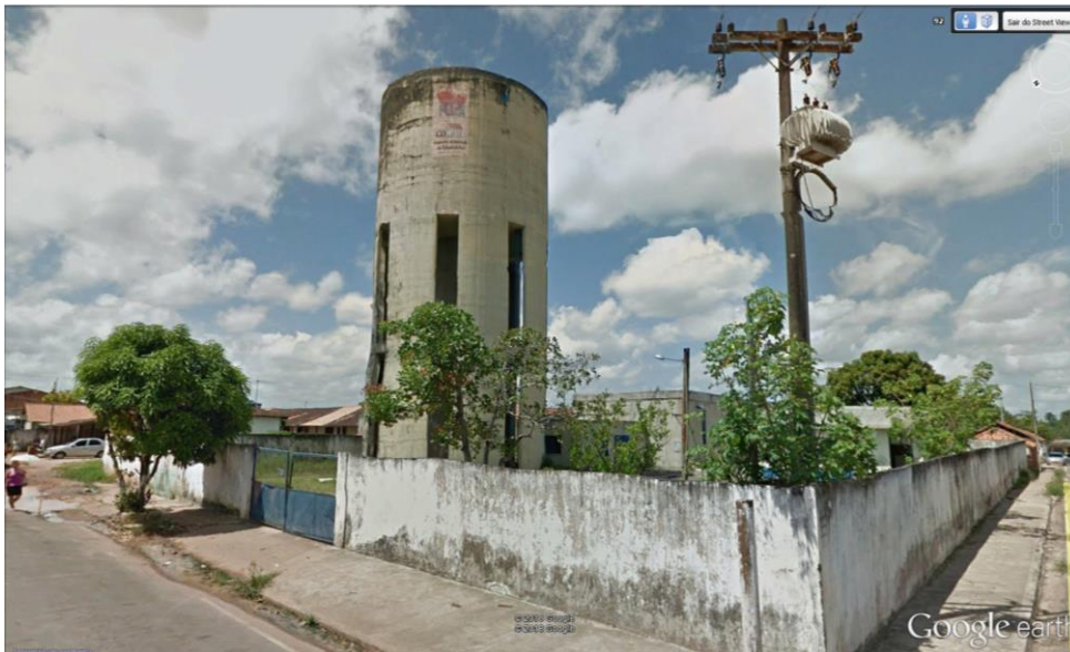
Figura 7: Imagem do Setor Paracuri – Subestação e Reservatório Elevado
