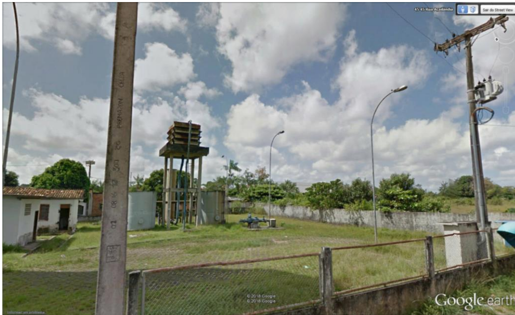
Figura 30: Vista da Área do Setor Canarinho – Subestação, ETA, Poço
