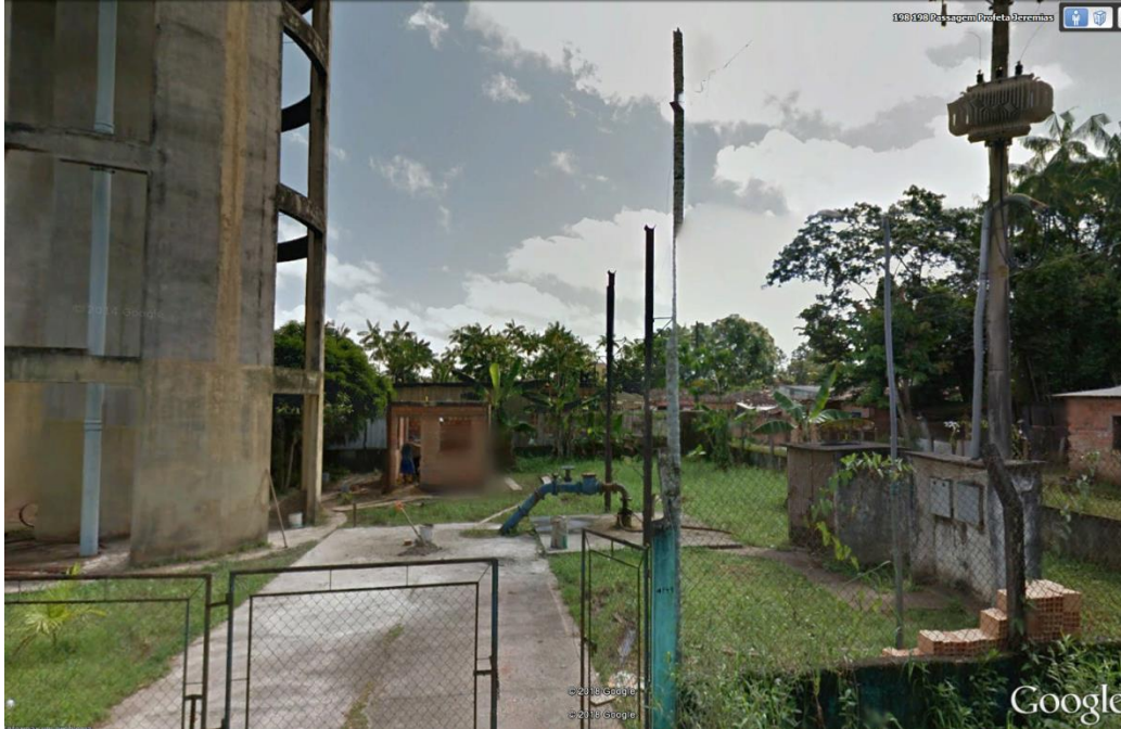
Figura 20: Vista da Área do Setor Pratinha I - Poço, Subestação e Reservatório
