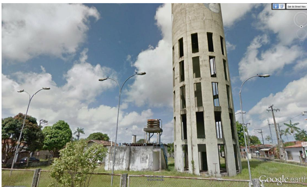
Figura 29: Vista da Área do Setor Canarinho – Reservatório Apoiado e Elevado
