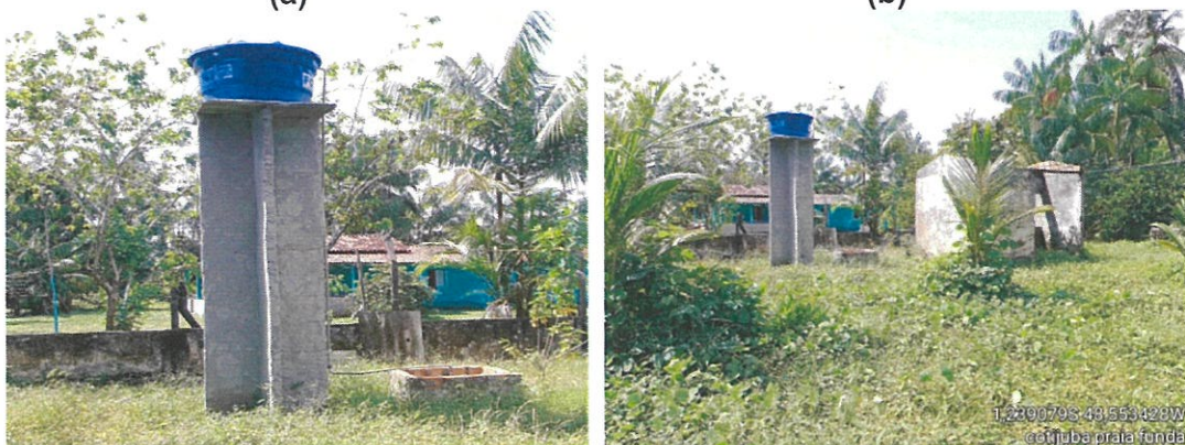
Figura 34: (a) e (b) estação de distribuição de água Praia Funda (a) (b)
