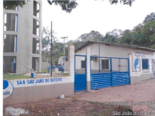
Figura 29: Faixa da Frente da Estação de Distribuição de Água
