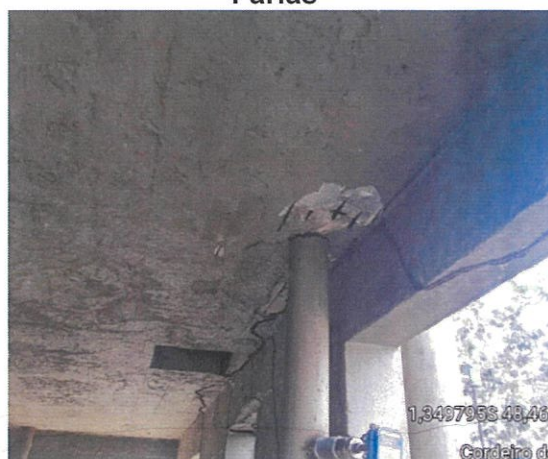
Figura 33: Trincas - reservatório de Água - Estação de Distribuição PAAR
