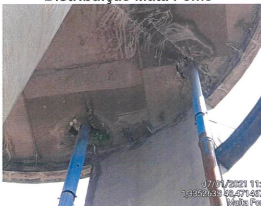
Figura 32: Trincas - base do reservatório de Água - Estação de Distribuição Mata Fome
