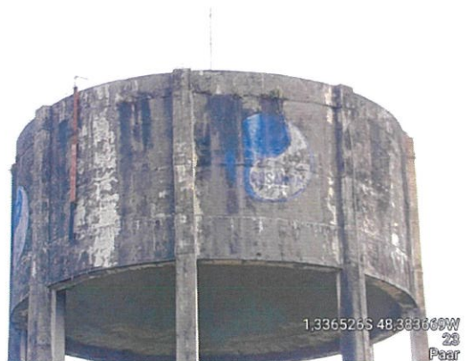
Figura 33: Trincas - reservatório de Água - Estação de Distribuição PAAR
