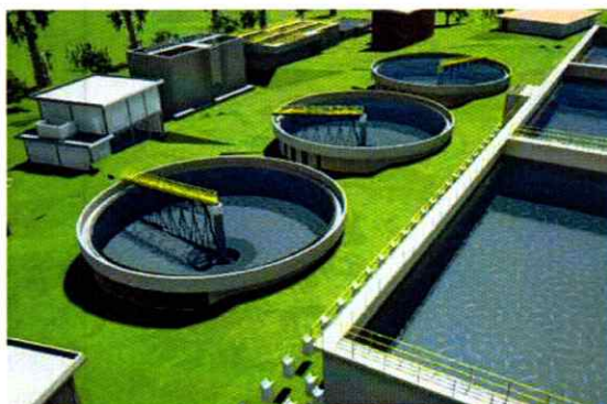
Figura 4 – Decantadores – ETE Leste Fonte: MPB Saneamento, 2019
