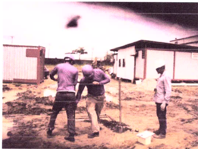
Foto 1 - Sondagem realizada com trado manual.
